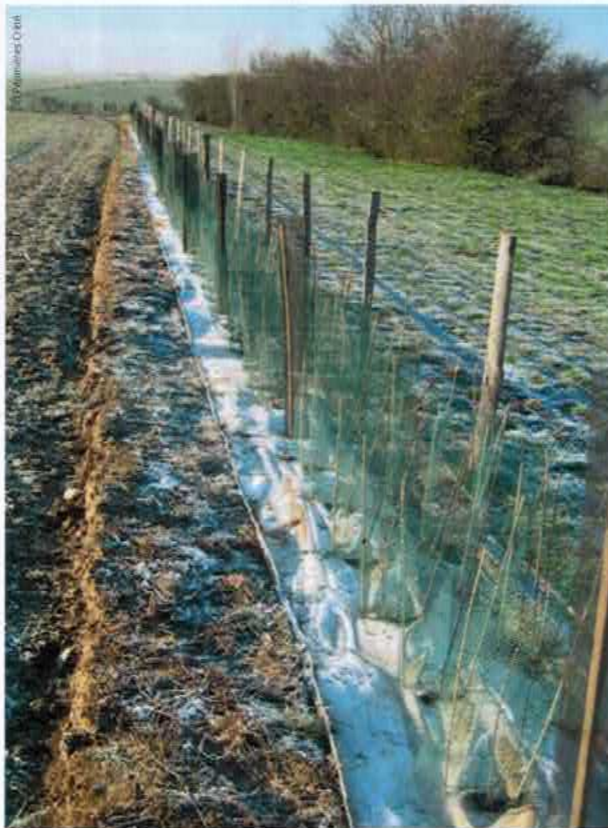
TRAVAUX COMPLÉMENTAIRES AVEC LA CRÉATION D'UNE HAIE DÉLIMITANT DEUX PARCELLES
